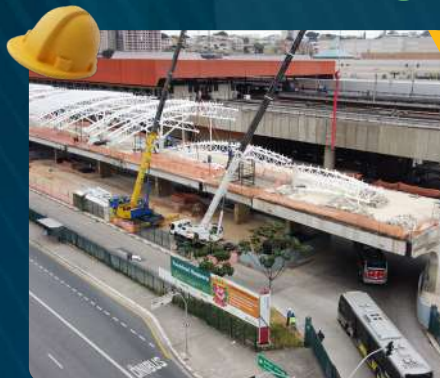
Novo Terminal Itaquera
